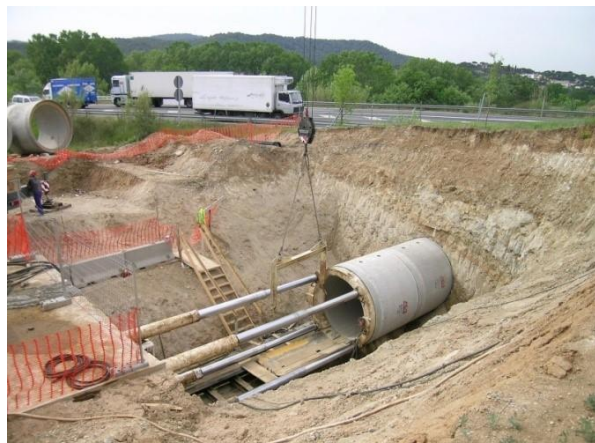
Tuneladora cruzando bajo carretera
