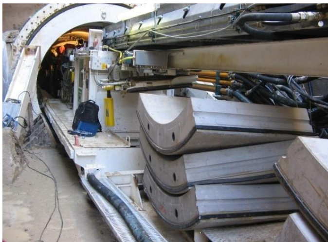
Dovelas en back up de tuneladora
