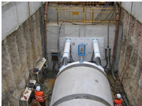
Pozo de ataque con sistema de empuje
