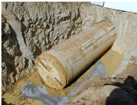
Salida de tuneladora en pozo de recepción
