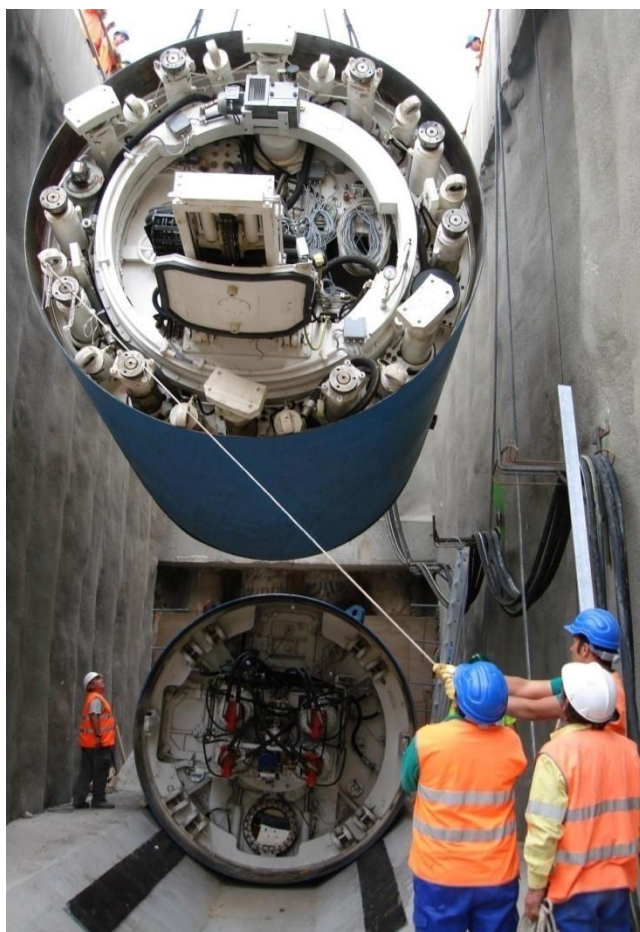
Montaje de tuneladora EPB
