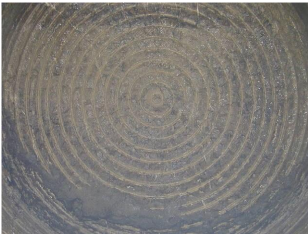
Frente de excavación en roca
