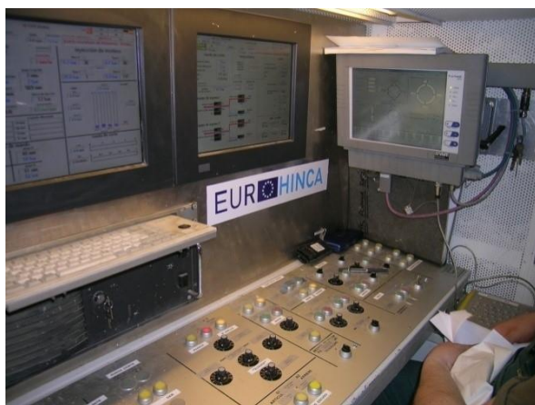
Cabina de control de tuneladora EPB
