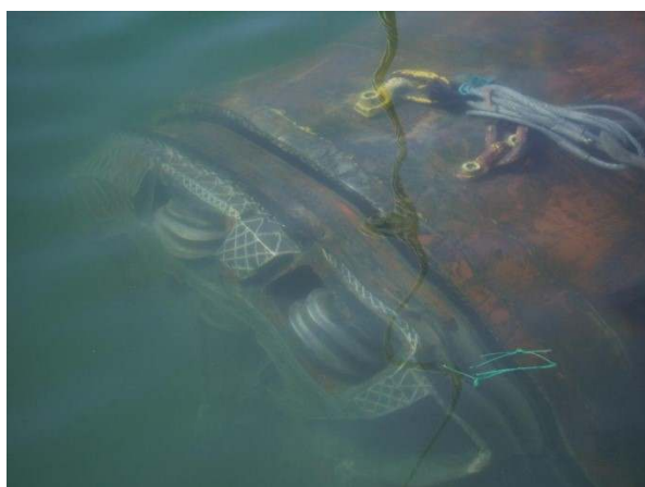
Rescate de tuneladora tras emisario submarino
