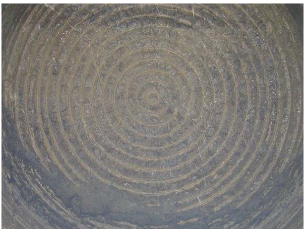
Frente de excavación en roca
