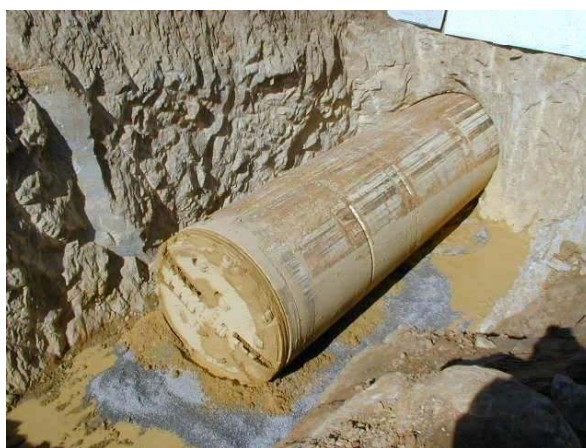
Salida de tuneladora en pozo de recepción
