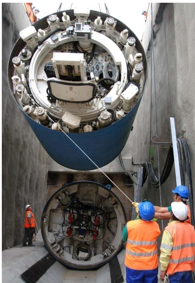
Montaje de tuneladora EPB
