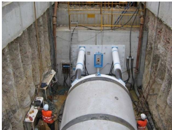
Pozo de ataque con sistema de empuje
