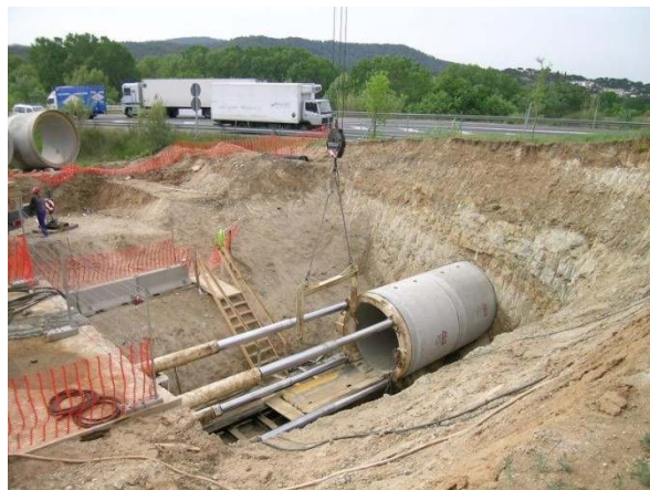
Tuneladora cruzando bajo carretera
