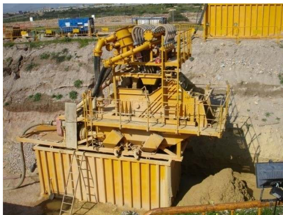
Planta de separación del material extraído
